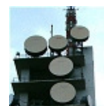
Tower of power (satt sammen av flere bilder, 408kB)
